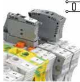
2 klemens arasında komponent montajı
